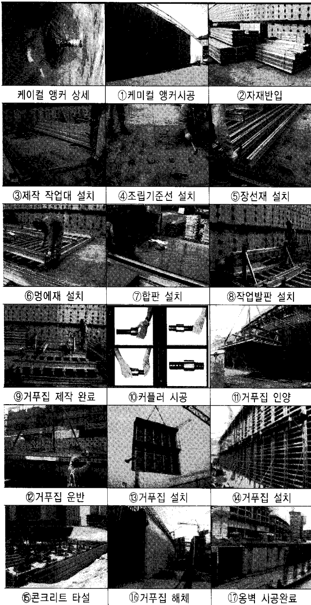
그림 10. A지하차도 거푸집 시공순서
