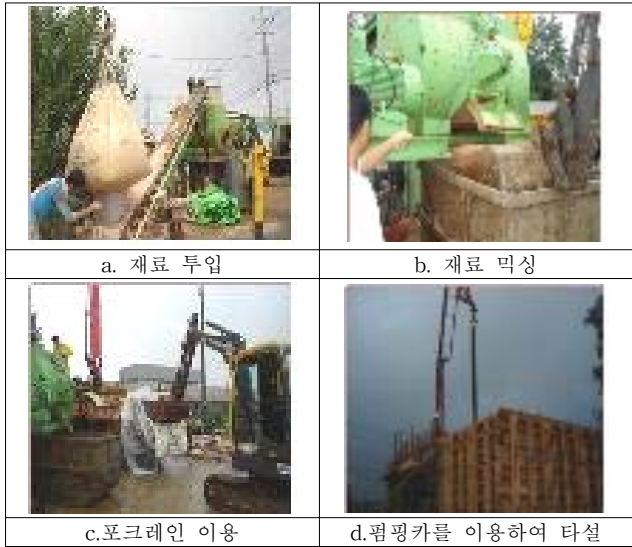
그림 8. 기둥·벽·슬래브 부위의 타설 방법
