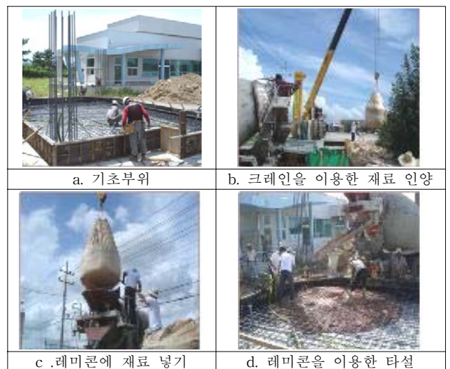
그림 7. 기초부위 황토콘크리트 타설 방법
