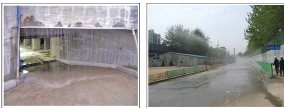
a) 워터커튼 시스템 b) 차량 이동통로 스프링클러
