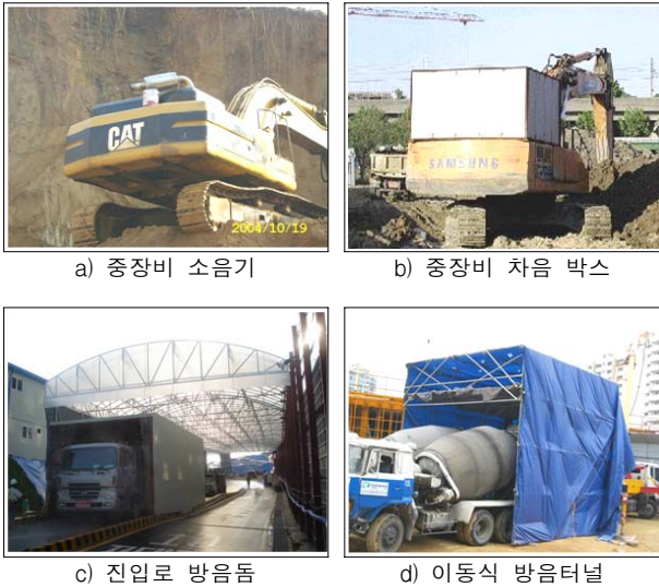
그림 3. 소음기·방음덮개·방음터널에 의한 소음저감시설 사례
