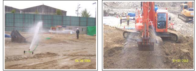
c) 이동식 스프링클러 d) 굴착기용 일체식 살수설비
