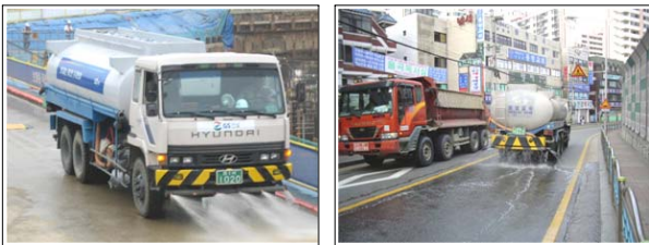
a) 빗물 재활용 살수차 b) 진입램프 포장 및 살수차 운영
