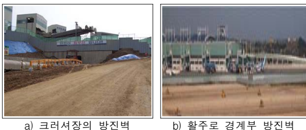
그림 4. 방진벽에 의한 날림먼지 저감시설 사례
