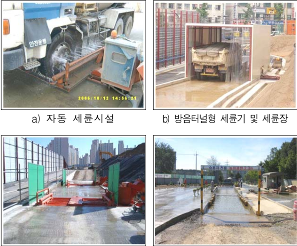
그림 7. 세륜시설에 의한 날림먼지 저감시설 사례
