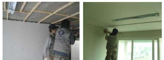
그림 3. 석고보드 시공 후 흡방습 천장재 설치 모습
