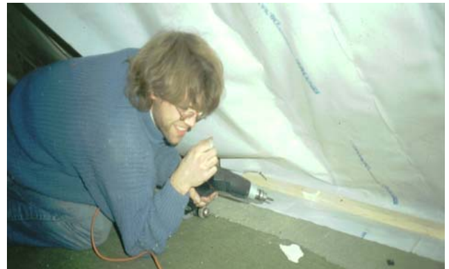
그림 8. 기밀시트를 시공하는 모습
