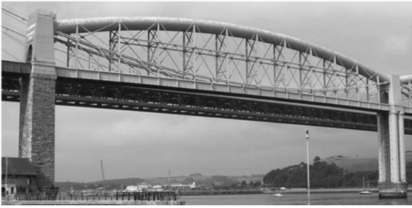
그림 4. Lenticular 구조시스템
