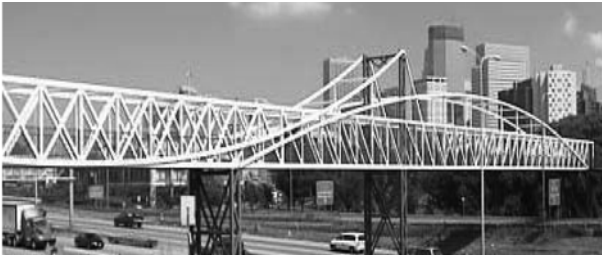
그림 5. 정아치와 역아치의 나열 구조시스템
