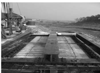
(d) 콘크리트 타설 및 양생
