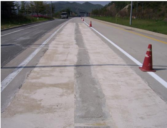
그림 4. 콘크리트 도로에 아크릴 콘크리트로 보수한 구간 전경
