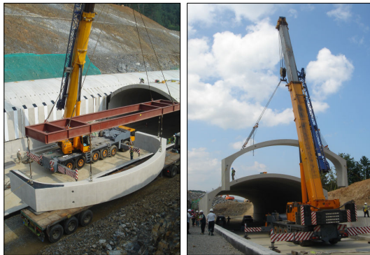
그림 7. P.A.B 인양 및 설치 전경
