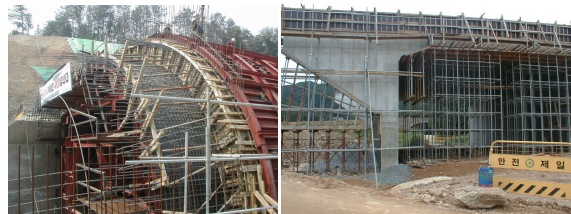
사진 2. 현장타설 개착식 터널 시공 전경
