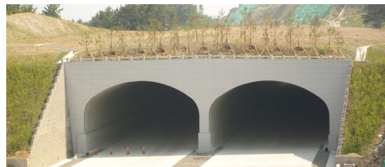
사진 1. 시공 완료 후 터널 전경
