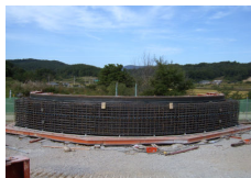
(c) 프리캐스트 상부 철근 조립
