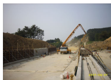
(b) 현장타설 기초부 시공
