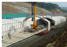
(h) 프리캐스트 설치
