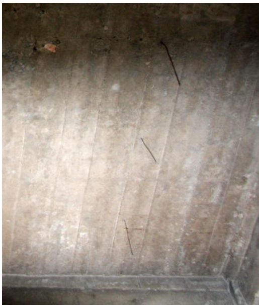
사진 5. 철근콘크리트 슬래브 밑면
