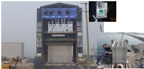
그림 9. 슬립폼에 의한 콘크리트 케이스 제작
