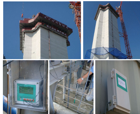
그림 11. 슬립폼에 의한 타워 콘크리트의 온도이력계측
