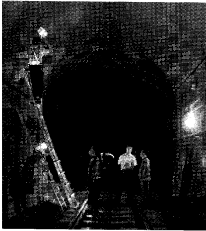
그림 9. 고덕 터널에 센서 노드를 설치하는 모습. Fig. 9. The scene in which sensor nodes are being installed in the Goduk Tunnel.
