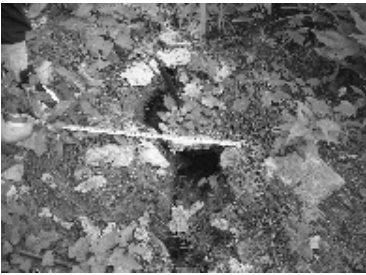
(a) 인장 균열 및 침하
