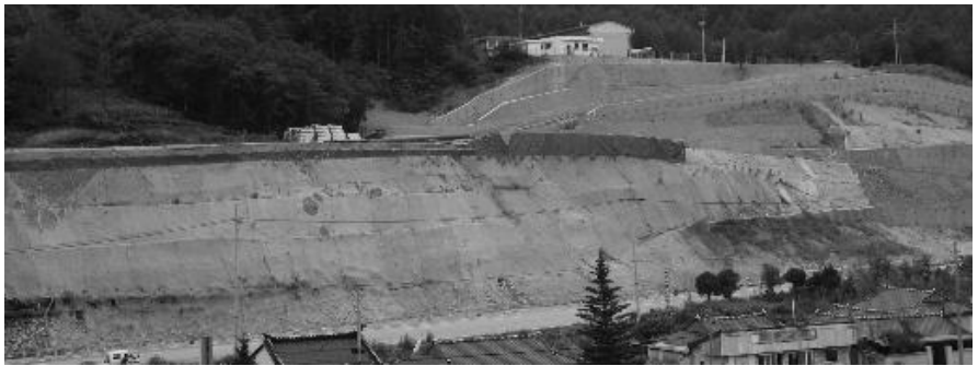
(b) 사면 붕괴 현장 전경
