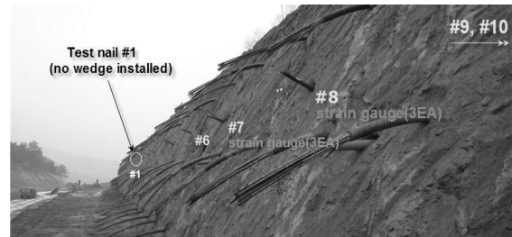
(c) 시공 후 모습
