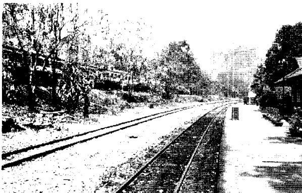
정거장은 약 21.9%구배를 이루고 있으나 중점정거장으로 운영하기 위하여 열차의 유치 및 기관차 방향전환 등을 위한 별도의 선로를 설치한 정거장 예
