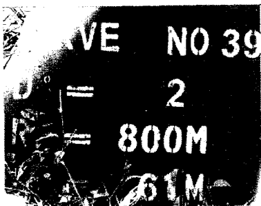
아프리카 나이지리아 및 케냐에서 표현되고 있는 곡선제원 100 feet 현의 중심각 2° 이때 곡선반경은 800m, 곡선길이는 61m이다
