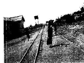
Sand Dune이 오고난후 모래가 쌓이고 있는 시막철도 및 이를 방지하기 위한 식재
