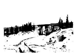
Sand Dune이 오고난후 모래가 쌓이고 있는 시막철도 및 이를 방지하기 위한 식재
