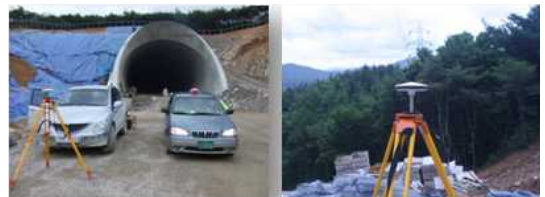
FIGURE 4. GNSS 장비 설치모습
