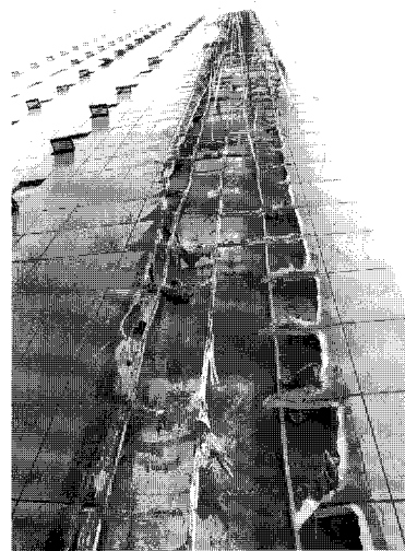
<Fig. 1> 외장재에 의한 수직 확산 화재 사례.
