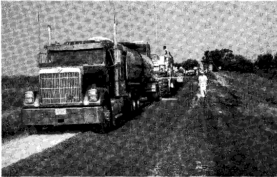
그림 3. 폼드 아스팔트를 이용한 지반 안정처리 시공 (Iowa State 2007년)
