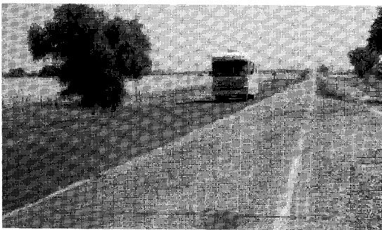
그림 8. 폼드 아스팔트 시공 후
