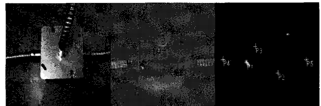
(d) Junction Box & MCIF Cable의 온도분포(3D) 및 위치별 온도 측정
