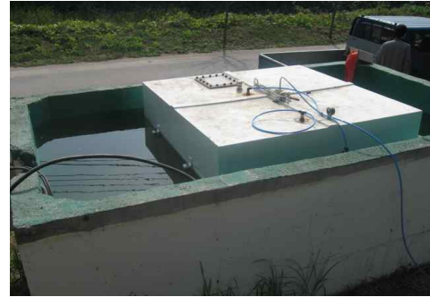
그림 9 변압기 완전 침수 시험 장면 Fig. 9 Test sight of the whole flooded for Transformer
