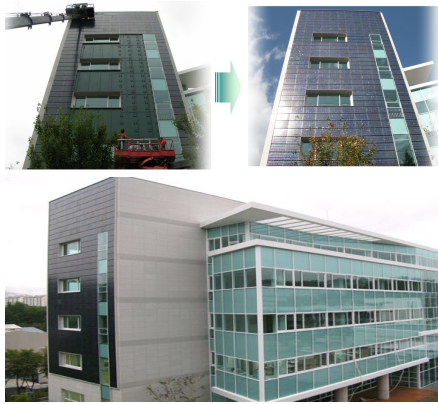
그림 5. BIPV모듈 설치 공법
