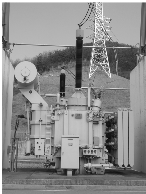
〈그림 6〉 345kV 변전소 변압기의 형상 및 도면
