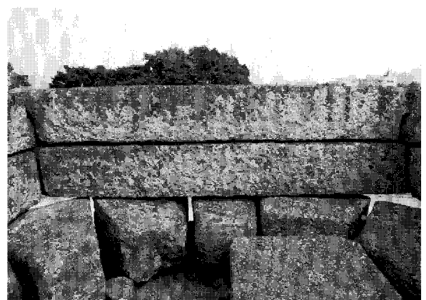
그림 7 경주 첨성대 전경 및 상부 상개 정자석 이격(2008년 현장조사)
