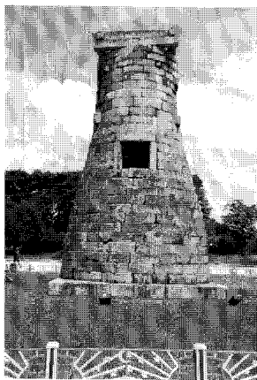
그림 7 경주 첨성대 전경 및 상부 상개 정자석 이격(2008년 현장조사)
