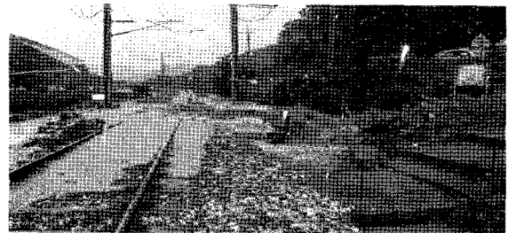
<그림 1> 폭우로 인한 선로침수 및 유실
