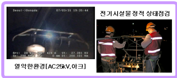
그림 1 전차선로 유지보수 일례 Fig. 1 An example of catenary maintenance
