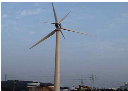
그림 1. 1MW 수평/수직 통합 이중로터 풍력발전시스템 (충남 서천)
