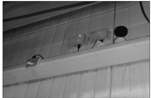
[사진 2] 차체 1반 우측 벽면에 소음, 분진, 습도, 온도 센서 설치 모습
