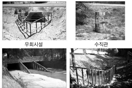
그림 8. 토석류 및 유송잡물 차단시설 설치사례
