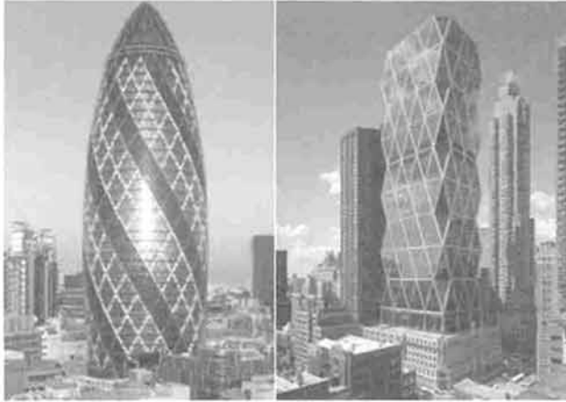
(a) Mary Axe(London) (b)Hearst Tower(New York) 그림 1. 다이아그리드를 사용한 건물
