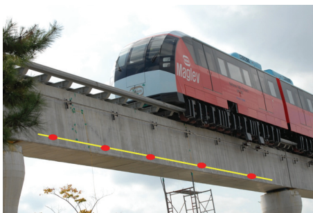
Fig. 12 현장실험한 자기부상열차 교량(KRRI)
