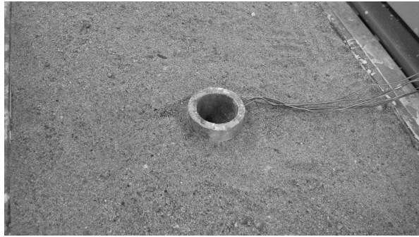
(c) 하중재하장치 설치
