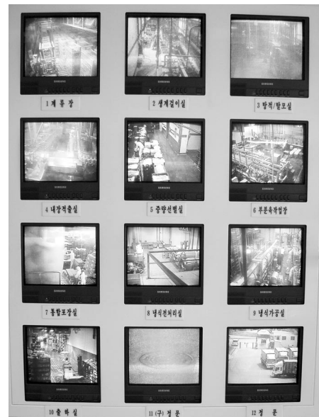
▲내부 사무실에서 처리공정을 한눈에 모니터링 가능(계류장→생계걸이실→탈지/탈모실→내장격출실→중량선별실→부분육작업장→통합포장실→냉식전처리실→냉식가공실→출하실)
