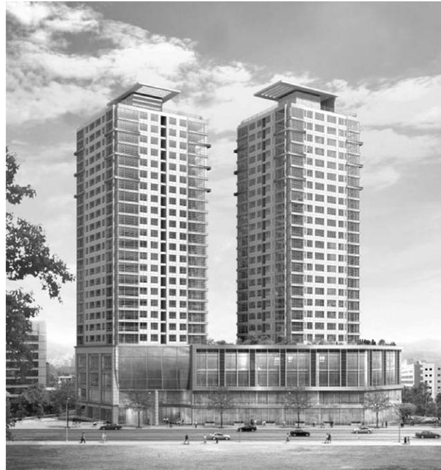
사당동 주상복합 건물은 평면크기 8.5m x 8.5~10.0m의 기본 모듈로 지하 7층, 지상 24층의 공동 주택 및 근린생활시설로 설계되었으며, 최초로 지하부 TOP-DOWN공법에 MHS합성보가 도입되었다. 기존 지하 철골에 비해 보 굵이 20cm 감소하여 층고 절감이 이루어졌고, 전체 층고 감소에 의한 터파기량 감소, 철골조에 비해 보 부재 골조비용 감소로 인한 공사비 절감, 처짐 및 진동에 유리하여 사용성 증대, 내화피복 불필요로 환경친화적인 건물관리, 품질확보를 통한 유지보수비 절감 효과 등이 기대되고 있다.
