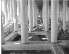
< 그림 5-5 RailWay Column, HighWay Column(내진보강) >
