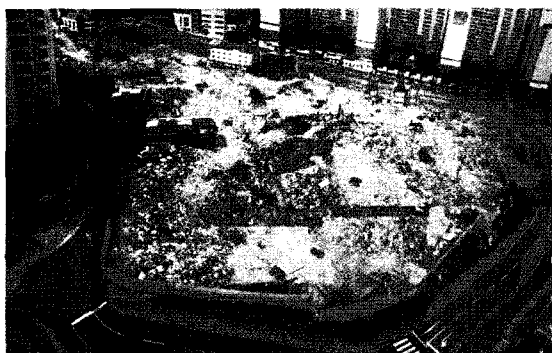
[사진 2] 현장대지 철거 후 전경
