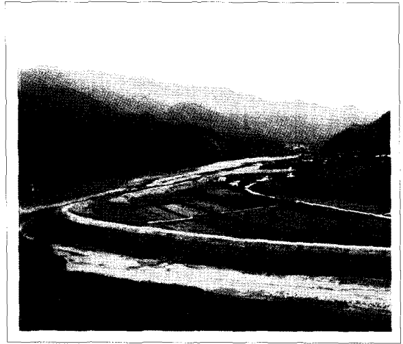
〈그림 5〉 복구공사 완료 후 전경
