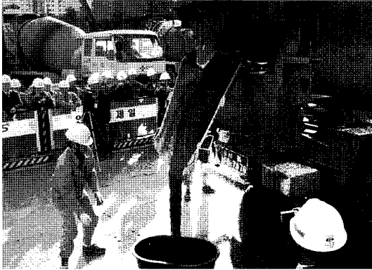
〈사진-3〉 현장도착 후 콘크리트 유동성 측정
