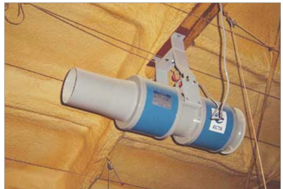
〈그림 5〉 순환 휀 설치
