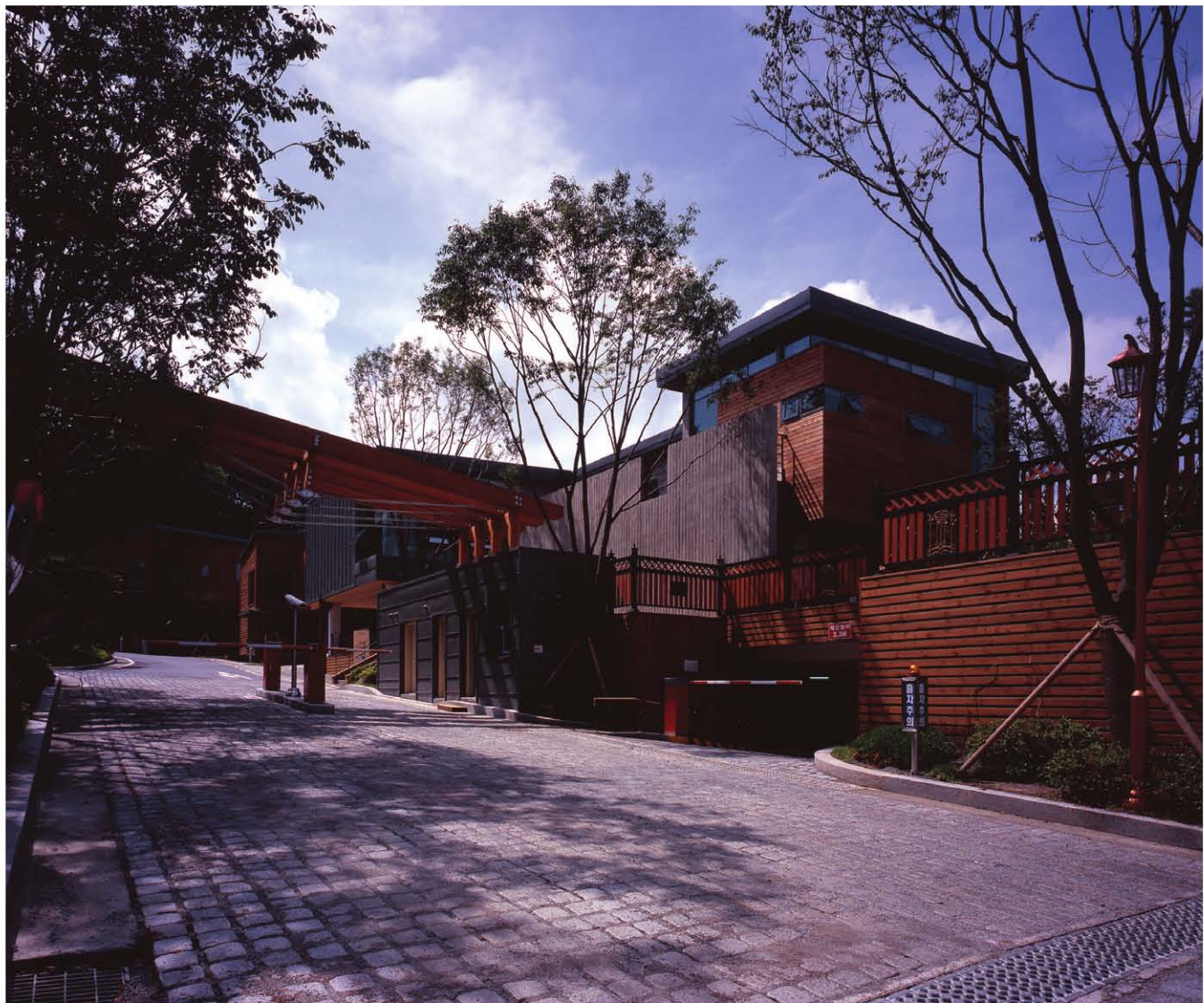
1. 단지입구에서 바라본 커뮤니티 및 게이트 2. 단지 내부 전경 3. 커뮤니티 4. 단지 내부 전경
