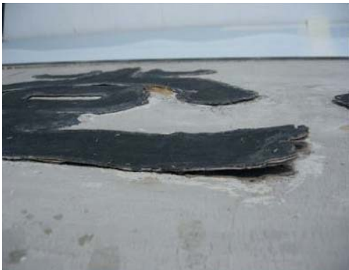
Figure 10. 글자가 들떠 있는 상태
