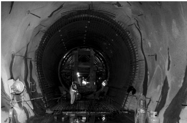
심층 배수 터널 공사. 신고리 1,2호기에 최초 적용되는 심층 배수 터널의 내부 콘크리트 라이닝 공사가 진행되고 있다.
