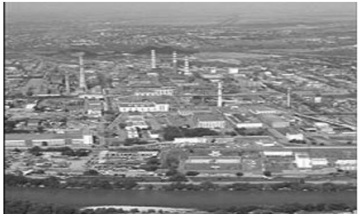
카자흐스탄의 UMP(Uiba Metallurgical Plant)
