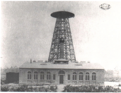
(그림 2) 1903년에 촬영된 187 feet의 Wardenclyffe Tower(Tesla Tower)의 모습. 이 탑은 세계 최초의 방송 시스템이었다. 테슬라는 이 탑을 이용하여 전리층을 통해 전세계로 전기를 공급하는 계획을 가지고 있었다. 전력은 나이아가라 폭포의 발전소로부터 공급받기로 되어 있었다.
