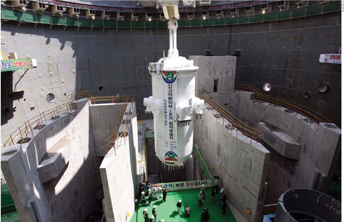
신고리 1호기에 최신형 원자로 설치
