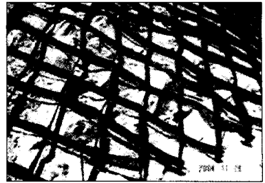
그림 23. 토목섬유를 이용한 침식 방지
