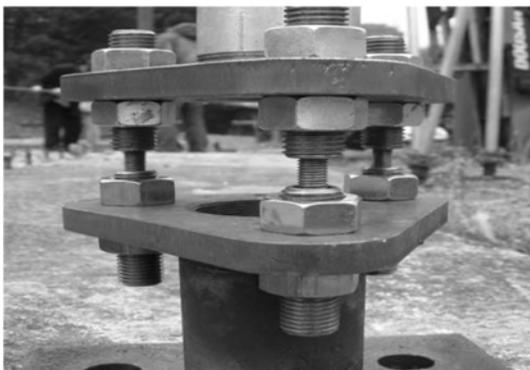
그림 1. 인텐티드볼트를 이용한 지주단부 장치
