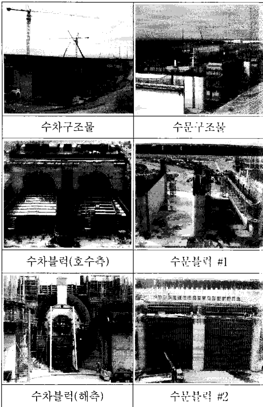
Fig. 17 조력발전소 시공 사진
