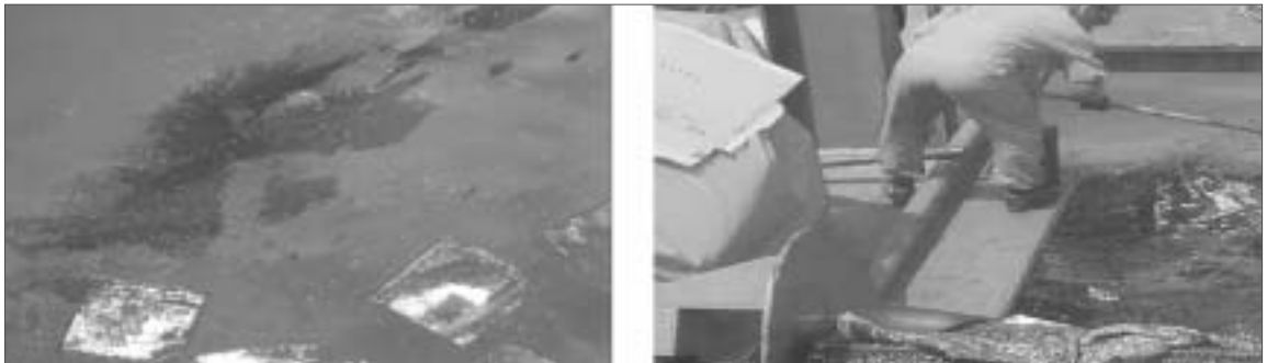
<그림 7> 청방선의 부유물 수거장치에 의한 유흡착재의 수거작업
