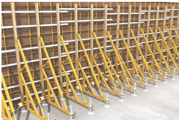
그림 1. 솔저를 사용한 지하층 합벽거푸집의 예
